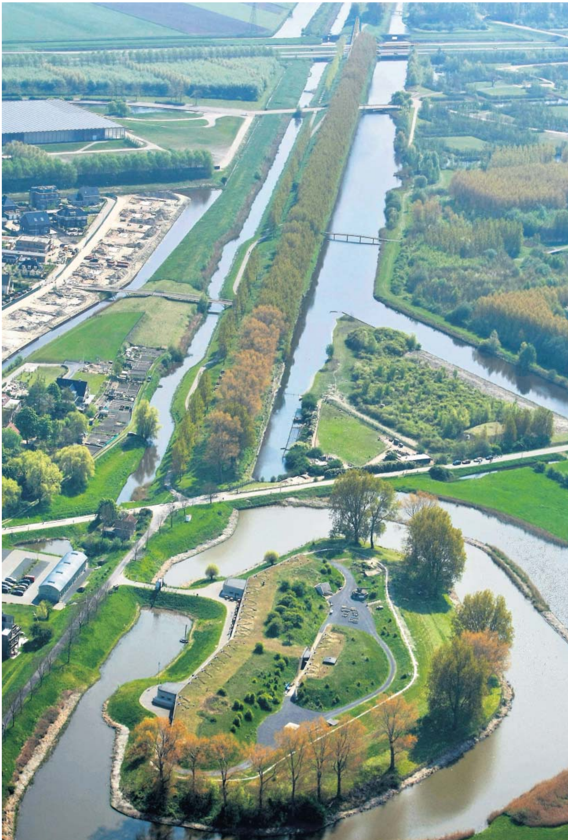
Fort Vijfhuizen aan de Spieringweg, met links de nieuwbouwwijk Stellinghof en omhoog lopend de Geniedijk.
